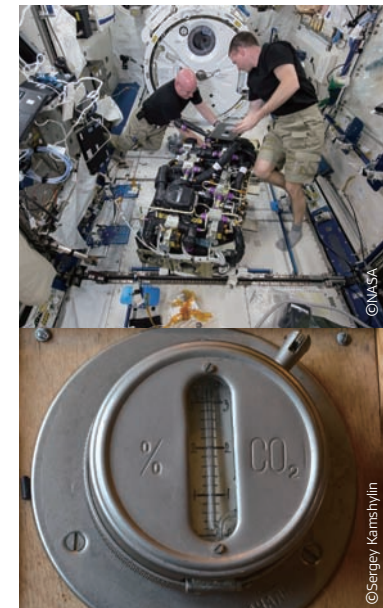
▲ 2015년 국제우주정거장의 우주인들이 이산화탄소 제거 장치(CDRA)를 유지·보수하는 모습(위). 옛날 잠수함의 이산화탄소 농도계(아래).
